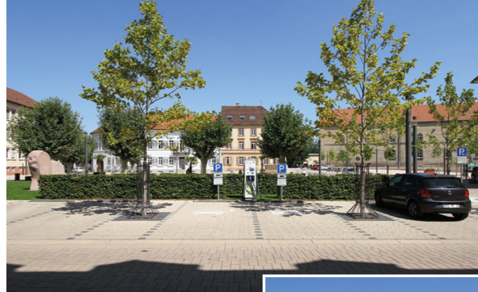
Rund 465 Meter Straße und rund 90 Parkplätze wurden in das städtebauliche Gesamtkonzept eingebunden
