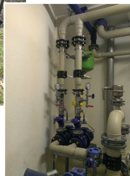
Druckerhöhungsanlage
