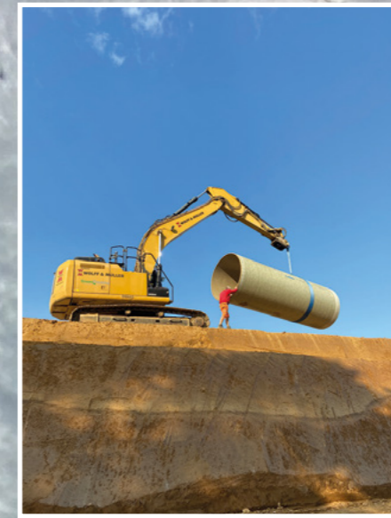
Einbau der Stauraumkanäle
