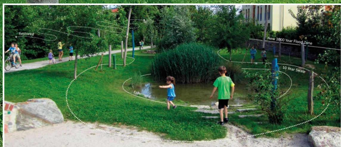
Großes Foto: Multifunktional genutzte Versickerungsanlage „Richard-Künzer-Straße“, Freiburg Rechts: Regenwassergespeister Teich mit wechselnden Wasserständen und Überlauf in Fließgewässer (Quelle: Ramboll Studio Dreiseitl GmbH 2019)
