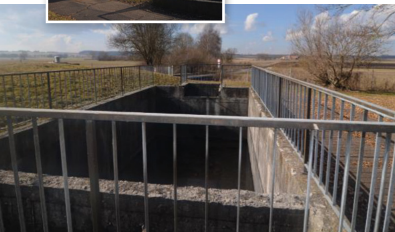
Das alte Wasserwerk würde nach Eröffnung des Neubaus rückgebaut. Das vorhandene Absetzbecken (unten) wird an das neue Wasserwerk angeschlossen
