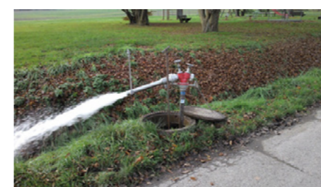
Für eine hydraulische Rohrnetzrechnung wird auch Druckabfall simuliert und in der Praxis gemessen
