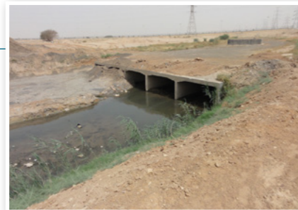
Zentraler Regenwasserkanal-Auslauf ins Wadi Solai
